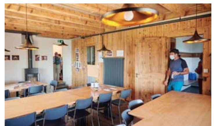
Les boiseries d'origine du réfectoire ont été sablées.
