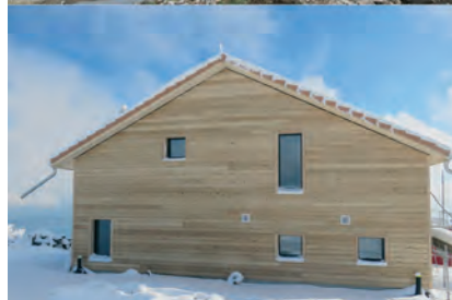
La cabane, vue du nord, avant-après.
