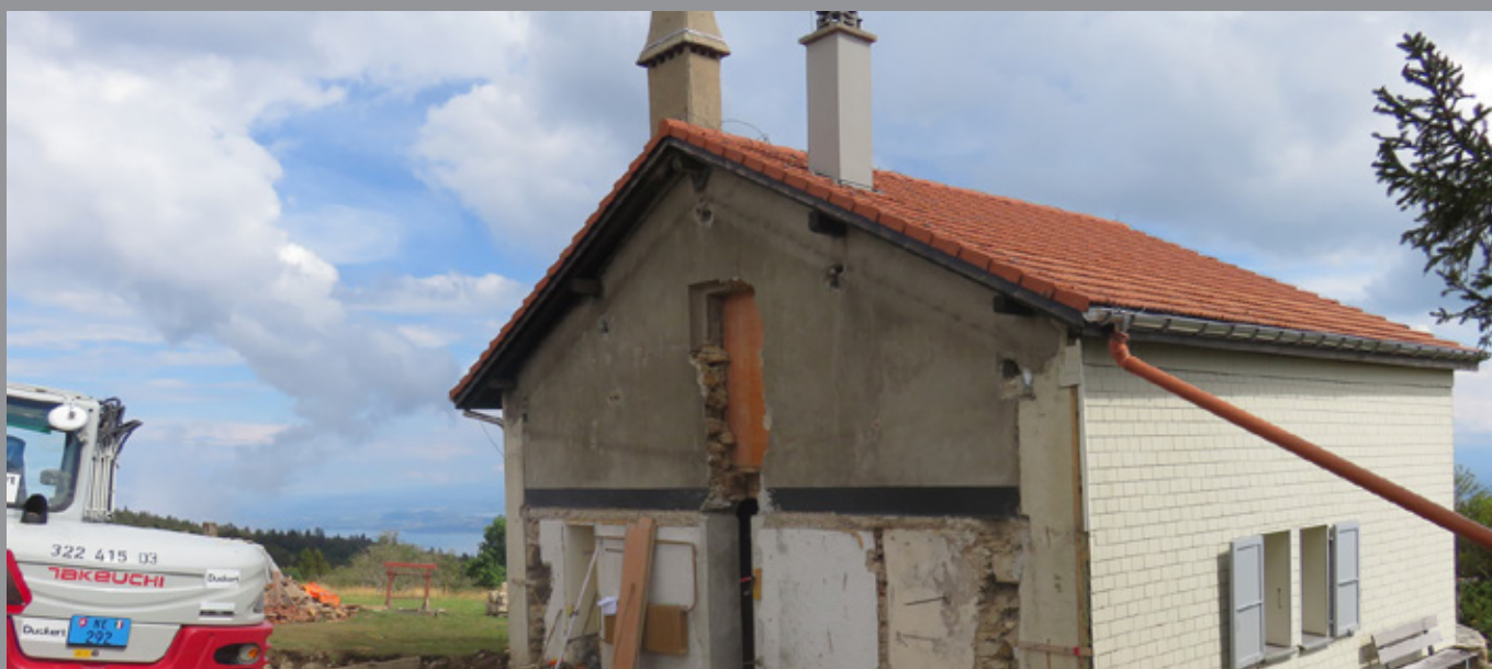
Démolition de la partie bucher - toilettes
