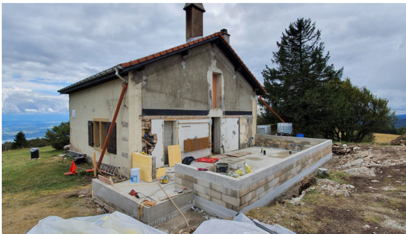
Transformation et agrandissement au nord de la cabane
