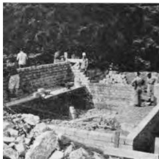
Les fondations en béton sont commencées le 18 juin 1969
