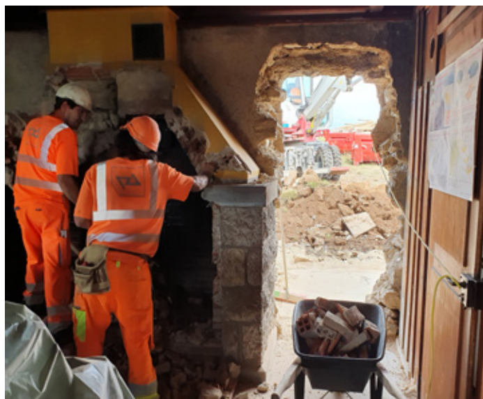
Travaux de démolition le 12 août 2020
