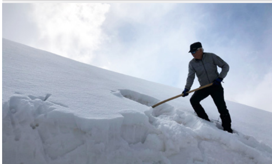
Partie des travaux d'ouverture de Saleinaz
